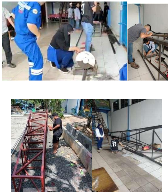
Gambar 5. Pembuatan Menara Pengeras Suara
