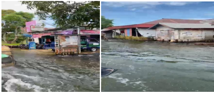
Gambar 1. Kondisi banjir di daerah Martapura Barat saat survey lingkungan.
