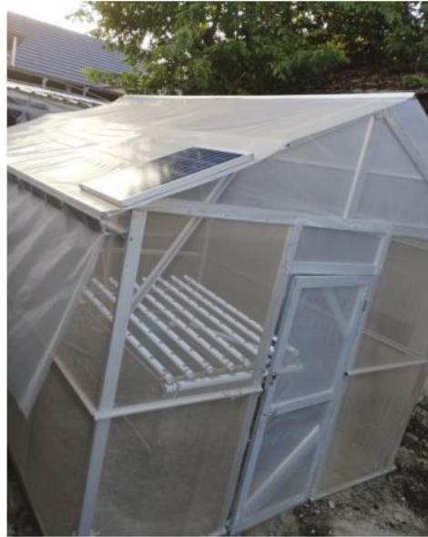
Gambar 4 Greenhouse teknologi hidroponik nutrient film technique (NFT) dengan panel surya dan sistem automatic transfer switch (ATS)
