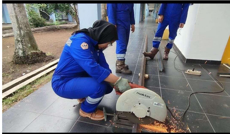
Gambar 5.3 Pemotongan bagian-bagian menara
