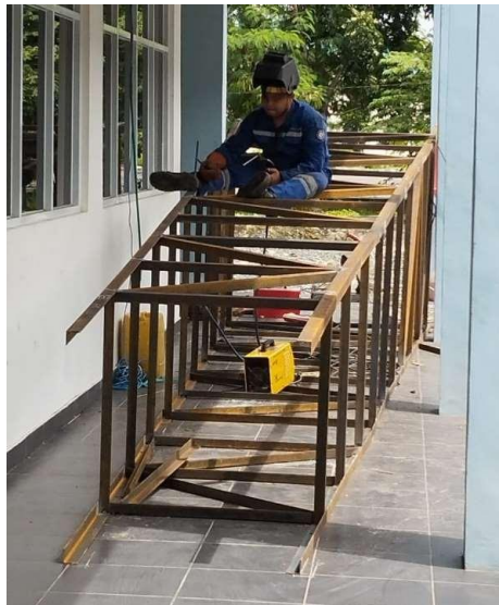
Gambar 5.4. Proses penyambungan bagian-bagian menara menggunakan las
