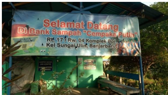
Gambar 1. Kondisi fisik bangunan Bank Sampah Cempaka Putih
